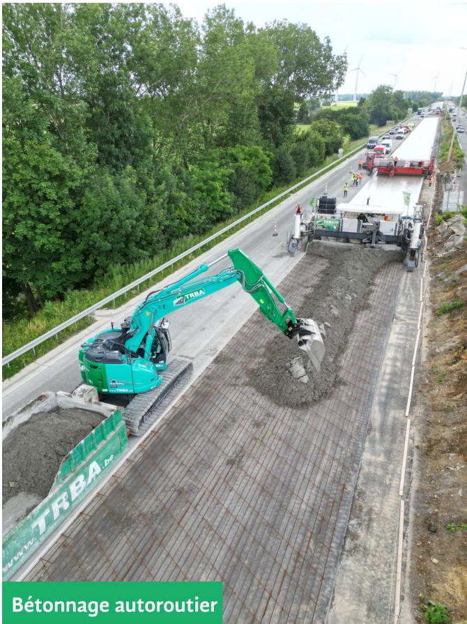
Bétonnage à la poutre
