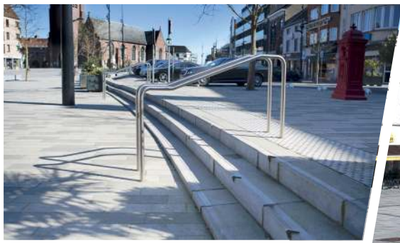
Pose de 3600 m d'éléments linéaires en pierre bleue.
