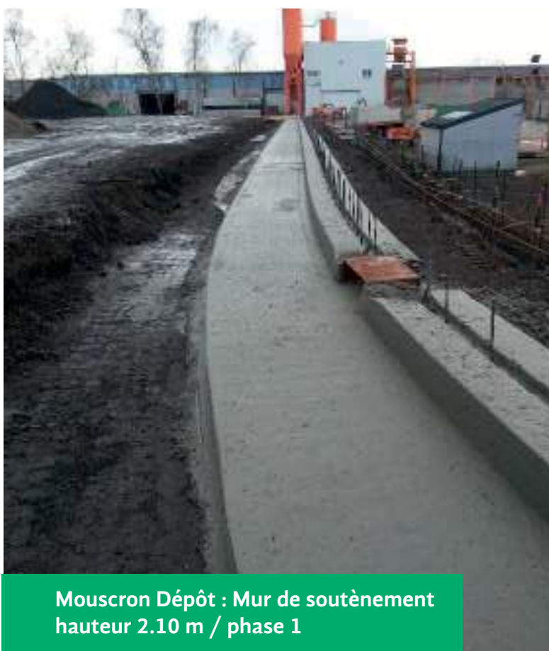
Mouscron Dépôt : Mur de soutènement hauteur 2.10 m / phase 1
