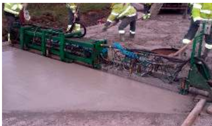
Derichebourg Marchienne au pont : Poutre vibrante thermique
