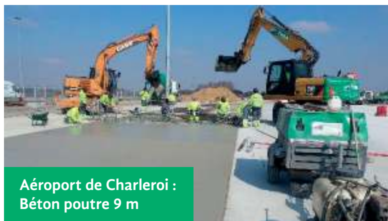
Derichebourg Marchienne au pont : Poutre vibrante thermique
