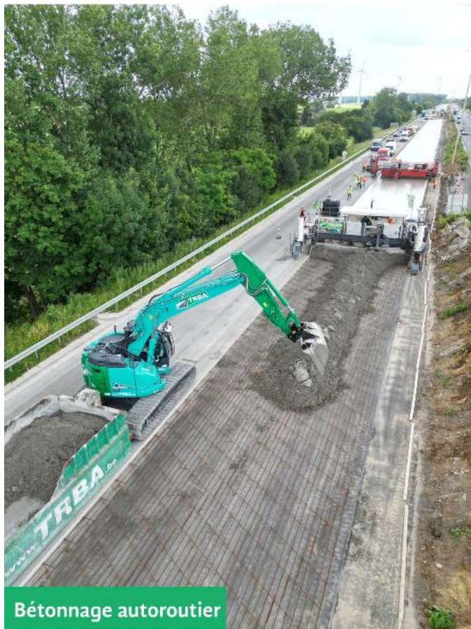
Bétonnage à la poutre
