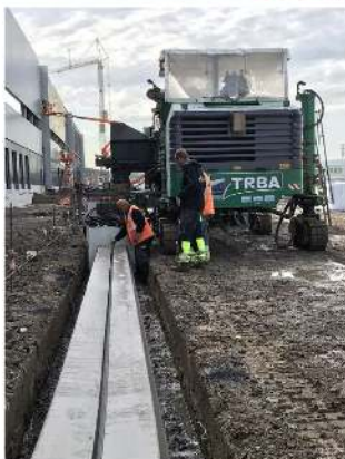
Bétonnage autoroutier
